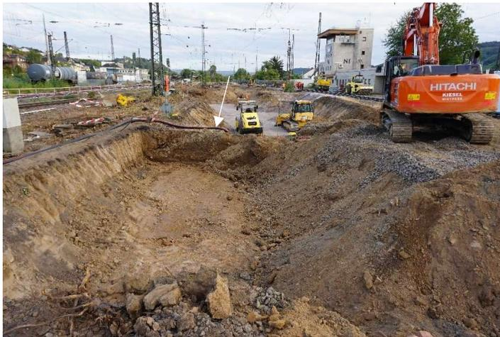
Abb. 5: Bildvordergrund: kleine und flache Baugrube südlich der Hauptgrube, weißer Pfeil: Verlauf des quer zur Gleisrichtung verlaufenden Kabelkanals mit verbliebenen Restverunreinigungen
