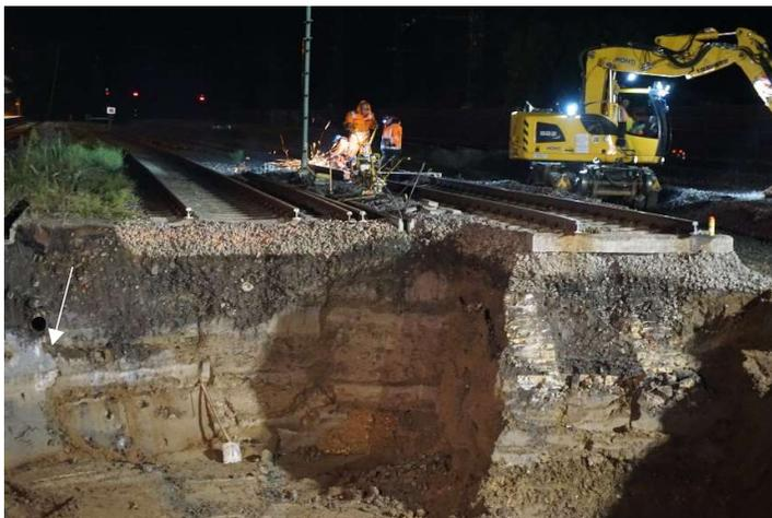
*Abb. 4: Nächtlicher Rückbau von Gleisanlagen im Süden der Baugrubenhälfte vor dem weiteren Fortschreiten der Böschung nach Süden, weißer Pfeil. offensichtliche Ölverunreinigungen*
