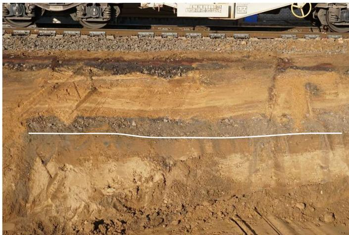
*Abb. 20: Südwestliche Böschung im Bereich der südlichen Baugrube mit relativ mächtigen Auffüllungen (weiße Linie: Basis der Auffüllung)*
