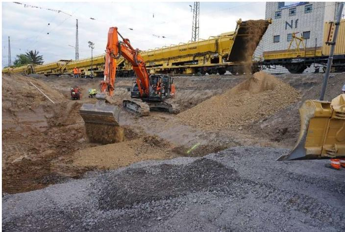
Abb. 9: Anlieferung des Tons (rechte Bildhälfte) zum Einbau in die Vertiefung nördlich des Oberleitungsmasten 1 (linke Bildhälfte), vorderes Bild Drittel: bereit eingebauter Lavalit (graues Gestein)
