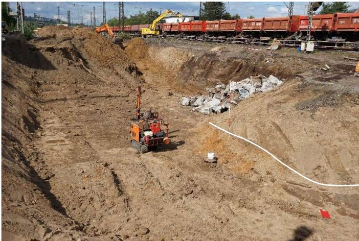
Abb. 22: Ausbiss der Hangendgrenze einer Kiesschicht innerhalb des Hochflutlehms (weiße Linie) entlang der Böschung am Kegelstumpf des Oberleitungsmastens 1
