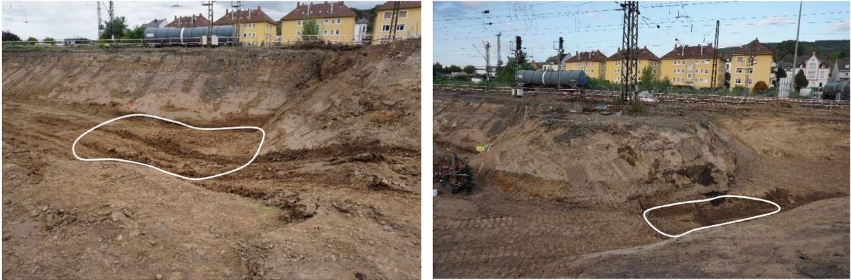
Abb. 7: Baugrubenvertiefungen (weiße Linien) nördlich (linkes Photo) und südlich des Oberleitungsmastens 1 (rechtes Photo) vor dem Einbau der Tonpfropfen
