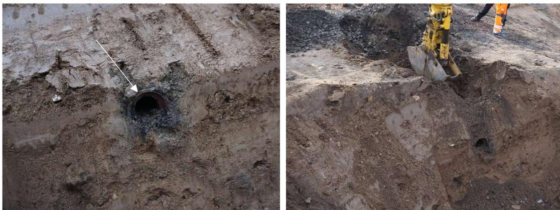
Abb. 3: Linkes Bild, weißer Pfeil: SW-NE-verlaufende Rohrbettung mit Ölverunreinigungen, rechtes Bild: Aushub von kleinräumigen Verunreinigungen außerhalb der eigentlichen Baugrube
