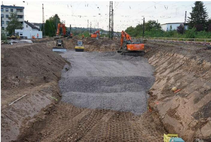
Abb. 8: Einbau des Lavalits in der nördlichen Baugrubenhälfte, Bildvordergrund: vorbereitete Fläche für den Einbau des Tonpfropfens nördlich des Oberleitungsmastens 1
