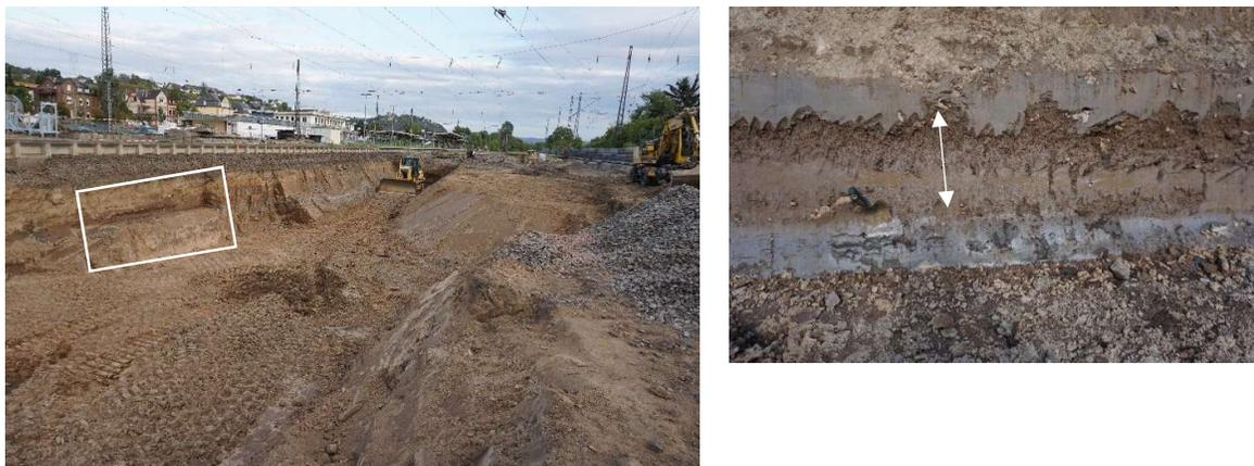
Abb. 10: Linkes Bild, weißes Rechteck: Lage der Böschungsabschnittes BP 24, rechtes Bild, weißer Pfeil mit Doppelspitze: Detailausschnitt BP 24, ölführende Sand-/Kieslage innerhalb des Hochflutlehms
